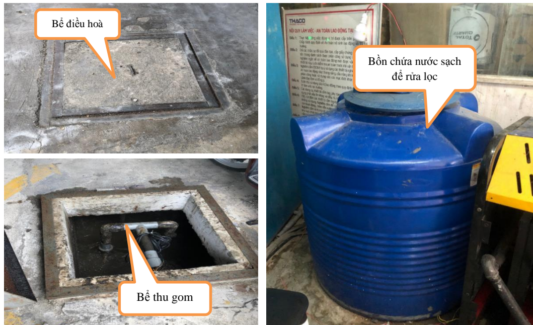
Hình 3.7. Một số hình ảnh về hệ thống XLNT công suất 15 m 3 /ngày đêm
